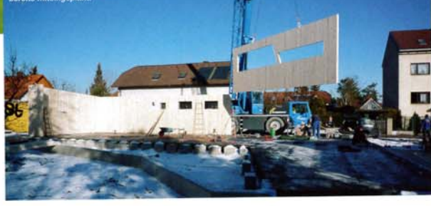
Sieben Monate liegen zwischen den beiden Fotos. Der Bungalow wurde mit Fertigteilen aus Massivholz gebaut. Sämtliche technische Möglichkeiten wurden bereits mitgeplant.
